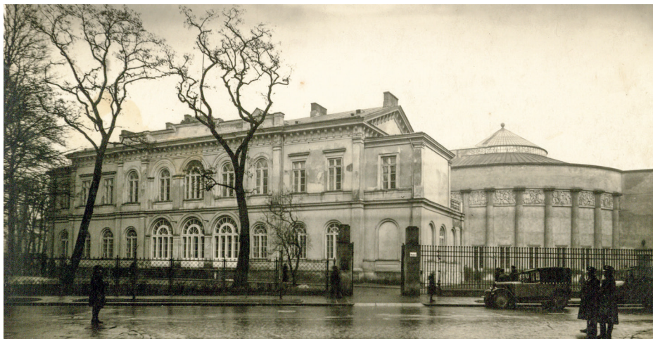
Kompleks parlamentarny po przebudowie, po 1928 r. Biblioteka Sejmowa
