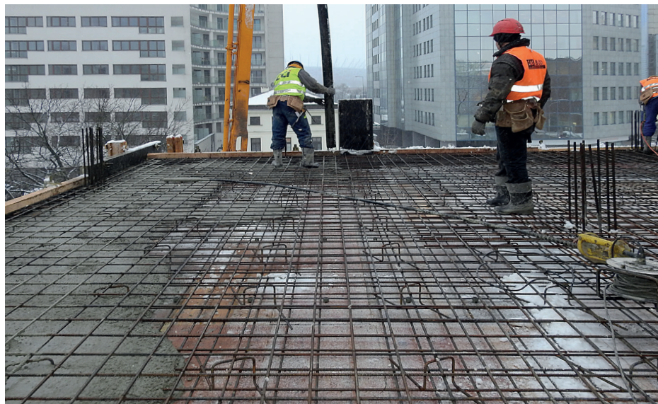
Remont generalny budynku T przy ul. Ludnej 4a, 4.02.2018 r. Biblioteka Sejmowa
